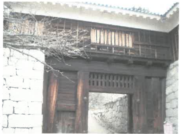
櫓門の例 松山城 筒井門
