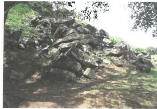
本丸の石垣。隅の石垣が滑り落ちゲニヤリと曲がっている。
