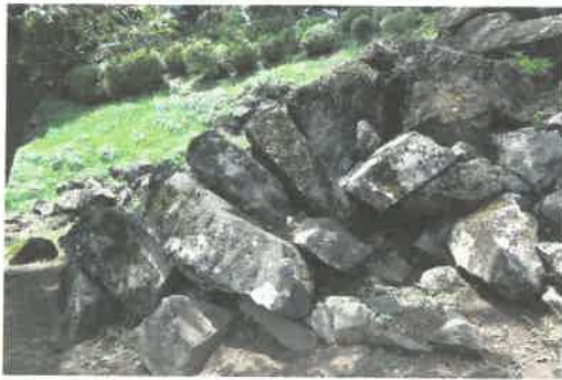
本丸の石垣。隅の石垣が滑り落ちゲニヤリと曲がっている。
